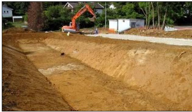
Figure 9 : Exemple de mise en place d'un bassin de rétention des eaux pluviales
