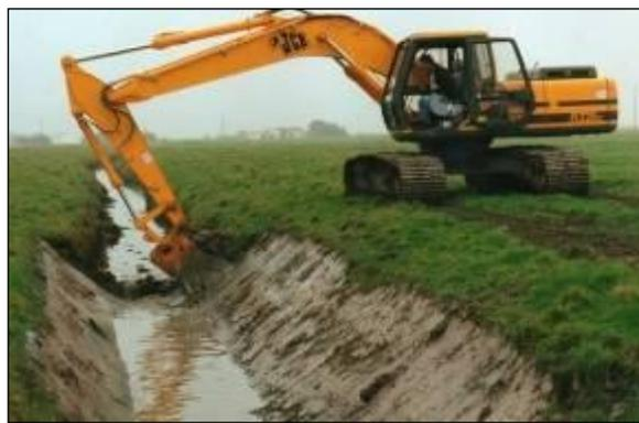
Figure 7 : Exemples de curage et reprofilage de fossé
