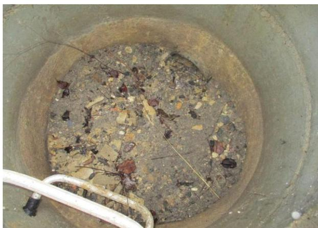
Figure 5 : Présence de dépôts et résidus dans un regard de la route du Bourg-Neuf à Azay-sur-Cher
