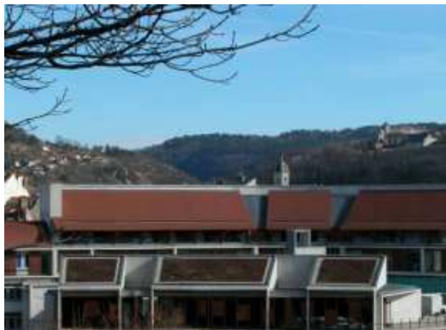
Toit végétal d'un lycée
