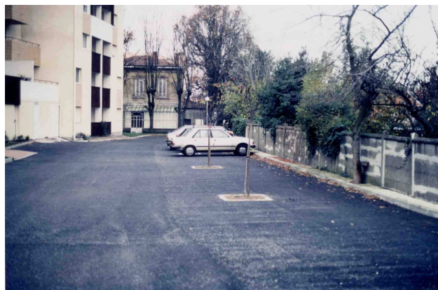
Tranchée sous enrobé poreux
