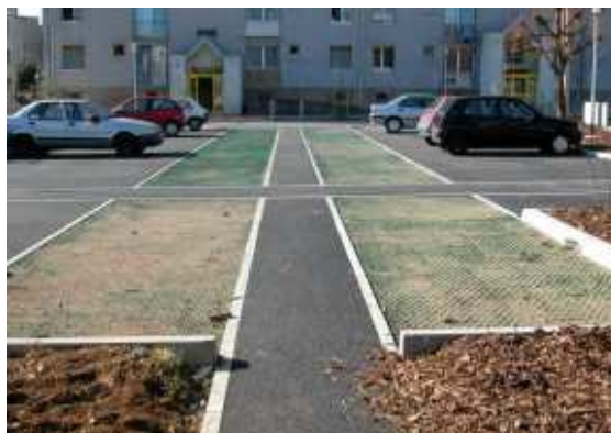
Structure réservoir recouverte d'un enrobé poreux
