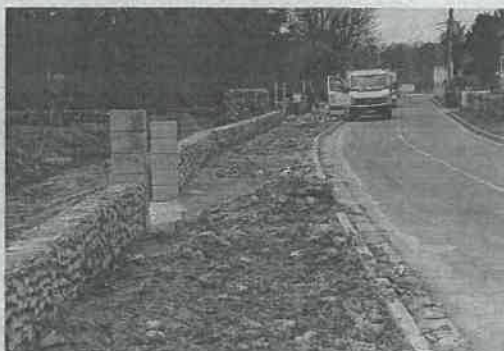
Le muret est reconstruit à l'intérieur d'un verger.
