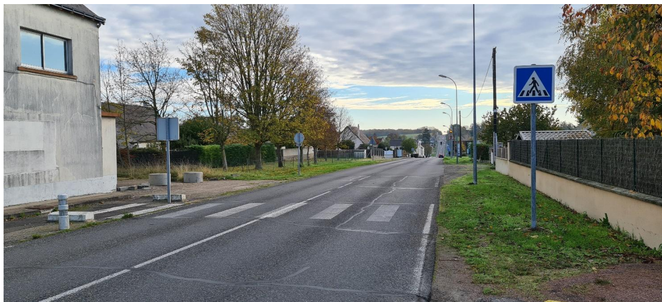
La RD 976 traversant le centre d'Azay-sur-Cher, vue vers l'est.
