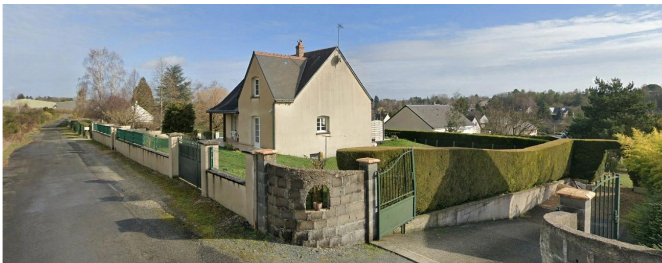
Vue 2 : depuis le chemin du Bourg Neuf, au sud du secteur
